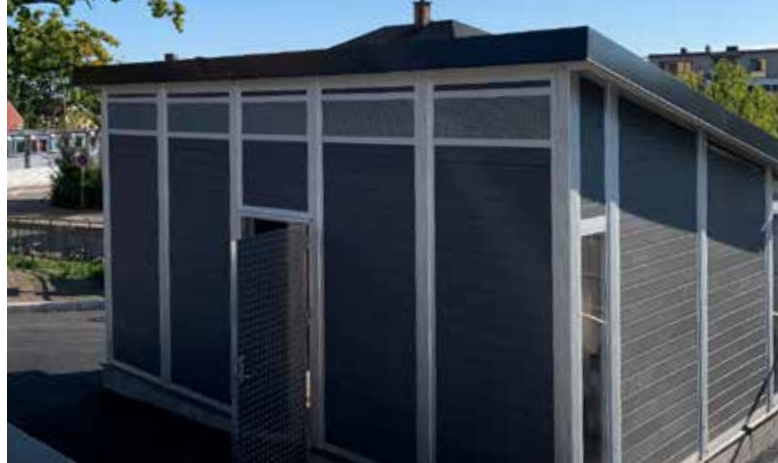
Miljøstasjon – avfallsrom – oppbevaring
