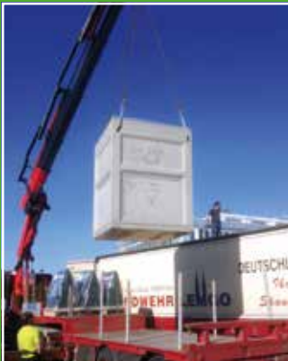
Lossing av trailer med kranbil.
