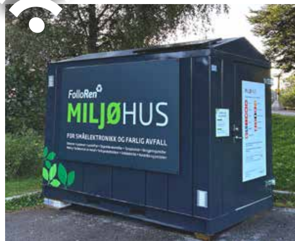
Follo Ren har belysning i miljøhuset som drives av et solcellepanel på taket. I tillegg sikker adgangskontroll m/app..
