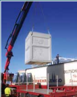
Lossing av trailer med kranbil.
