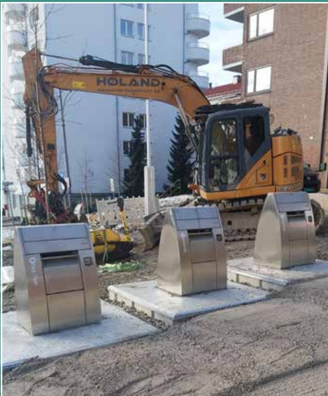
Innkastoppene, denne gangen i børstet stål, er på plass og vel installert av Enviropacs serviceavdeling.
