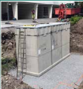
Med utgraving oppe og nede blir det enkelt å plassere betongbeholderne helt inntil hverandre.
