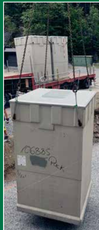
Enkel montering. Både inner- og yttercontainer løftes på plass i ett og samme løft.
