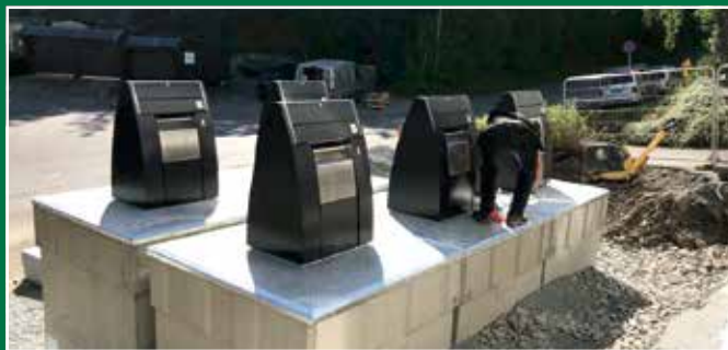
Med utkraging oppe og nede blir det enkelt å plassere containerne helt inntil hverandre.
