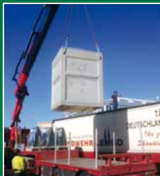
Lossing av trailer med kranbil.
