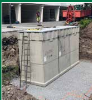
Med utkraging oppe og nede blir det enkelt å plassere containerne helt inntil hverandre.
