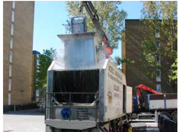
Rengjøring av en helt nedgravde avfallscontainere
