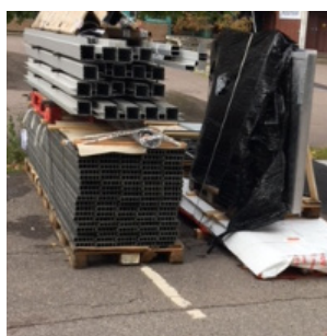
Miljøhuset støpes og monteres på stedet.
