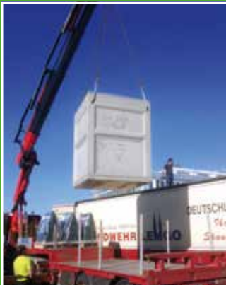
Lossing av trailer med kranbil.
