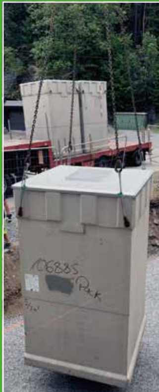
Enkel montering. Både betong-beholder og innvendig avfalls-beholder løftes på plass i ett og samme løft.
