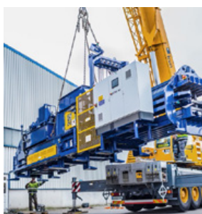
Installasjon av AVOS 1810 B5-90/100
