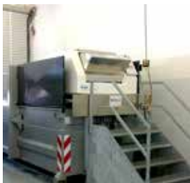
Trapp gir enkel tilgang til innkastet på komprimatoren. Veieenheten er separat, kan demonteres og flyttes over i en annen komprimator.
