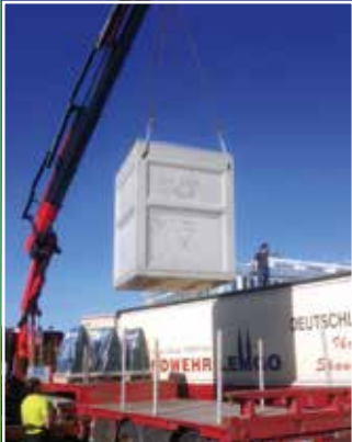
Lossing av trailer med kranbil.
