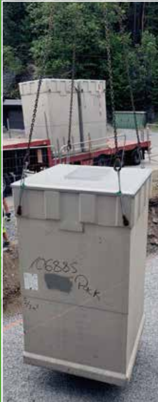
Enkel montering. Både inner- og yttercontainer løftes på plass i ett og samme løft.
